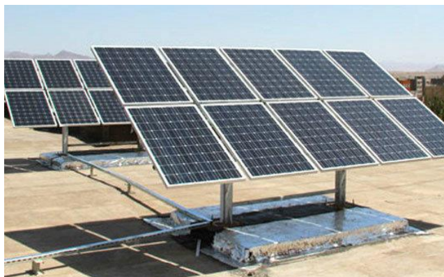
سازه سقف خانه
